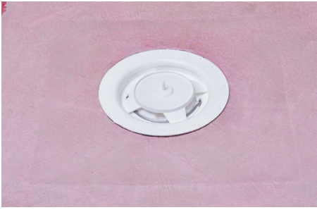
1. Montera PURUS-hållaren innan du monterar ARDEX STA tätark.
